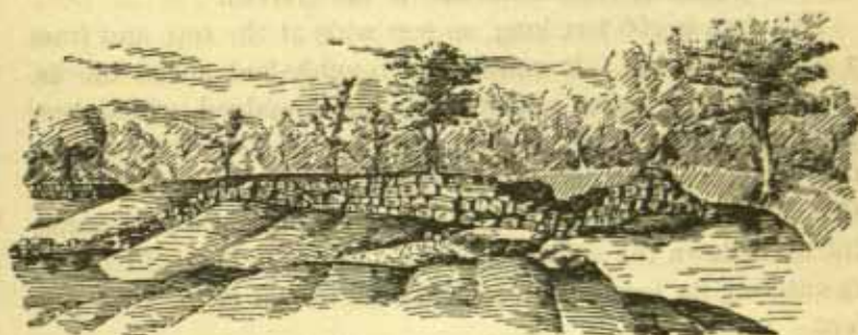
FIG. 147. The Allekatu Dam.
